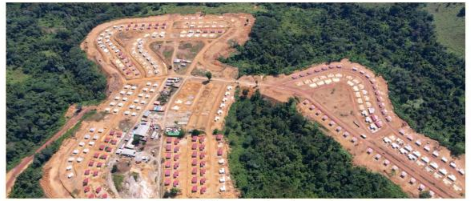
Vue aérienne du chantier.
