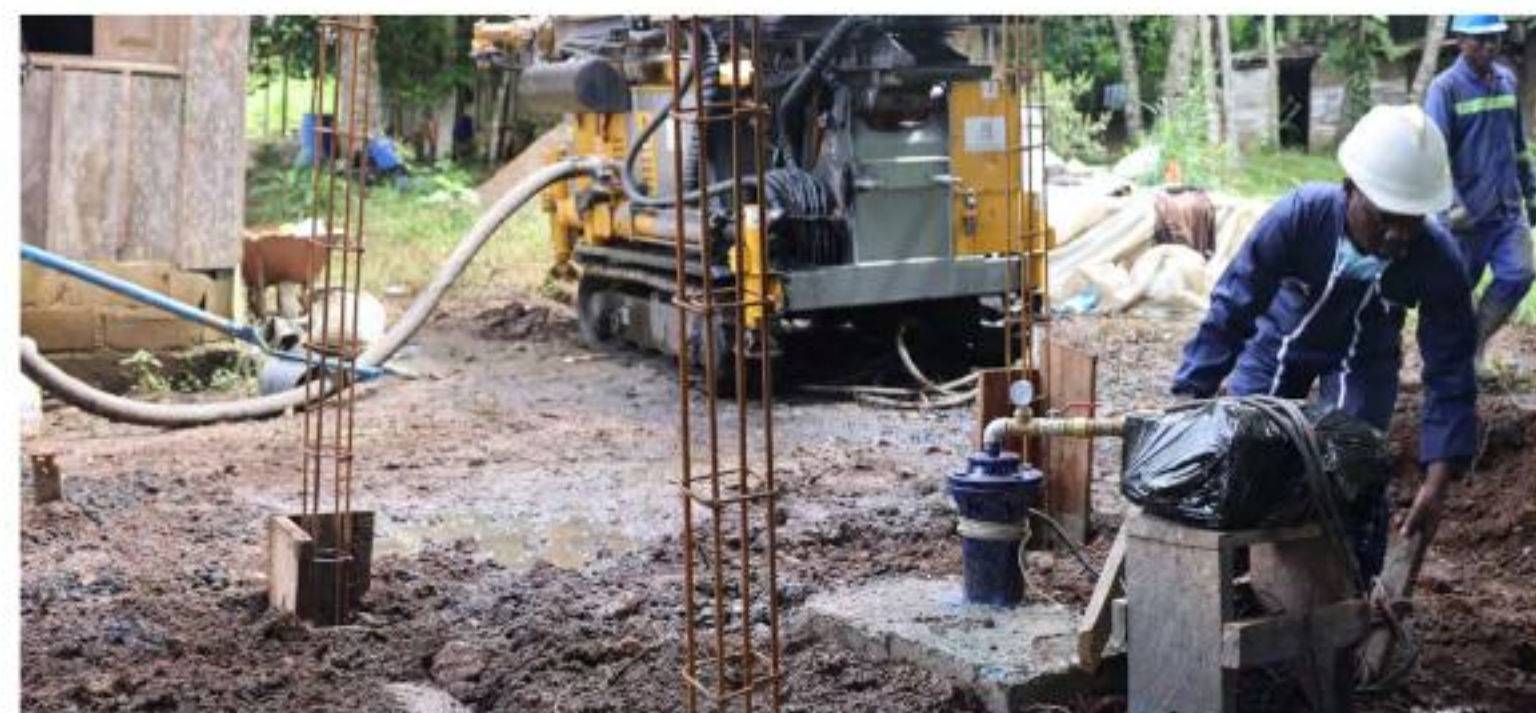
Forage d'eau potable en cours de construction au village Massango 2.
