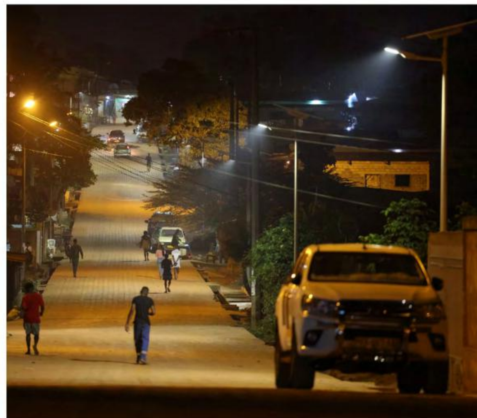
Le chantier prend forme.
