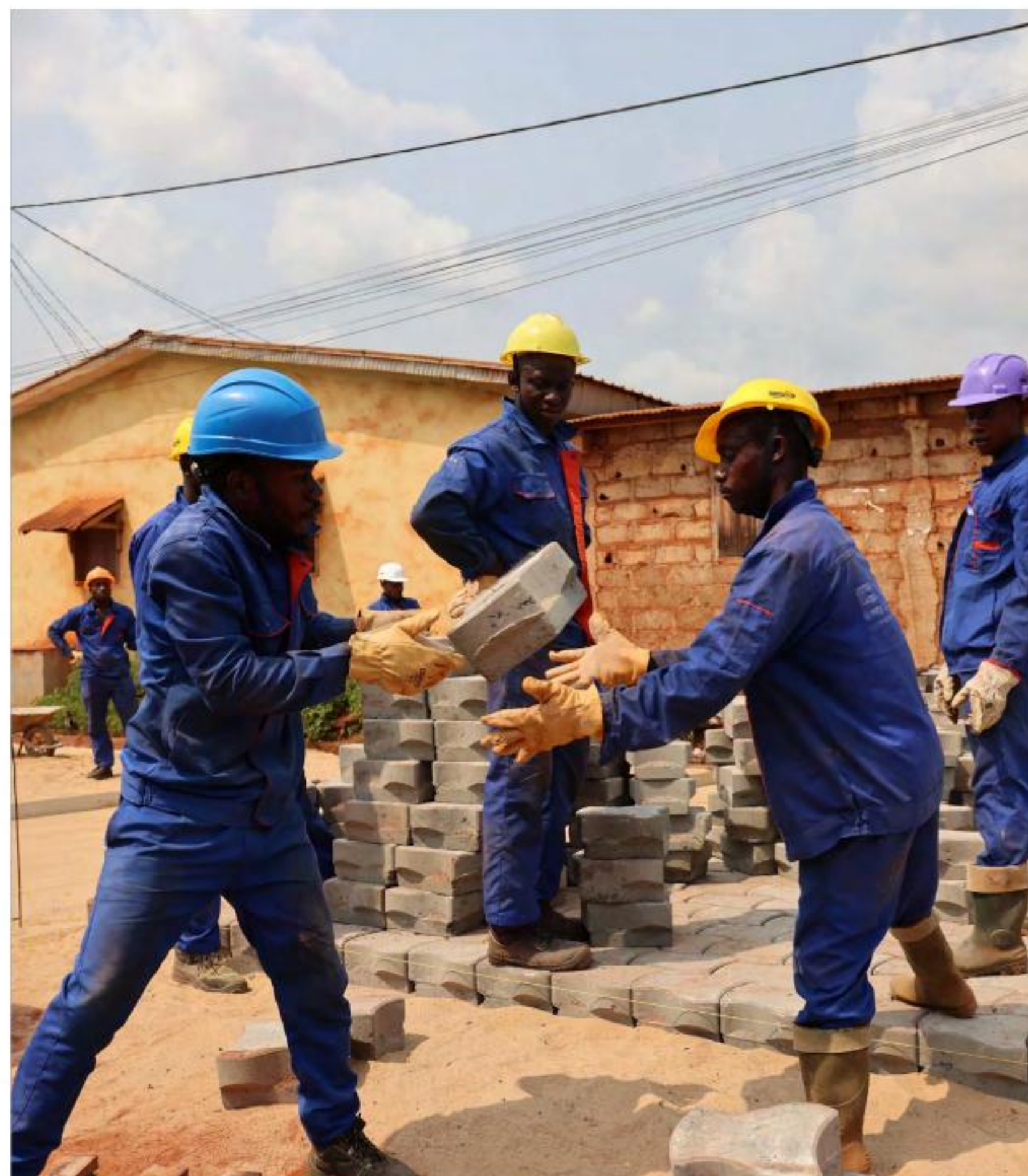
Pose des pavés sur les axes secondaires de Moanda.
