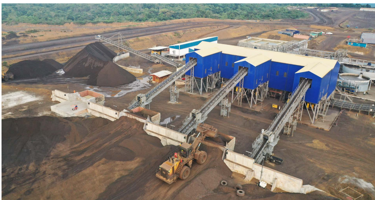
Vue aérienne des laveries modulaires.
