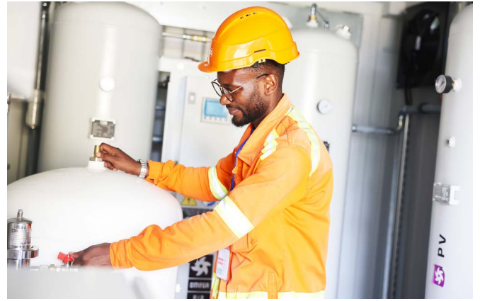
Un des techniciens à pied d'oeuvre.
