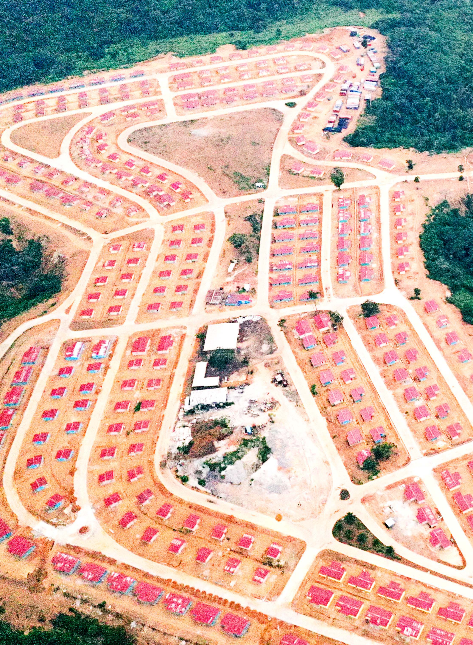
Vue aérienne de la cité de relogement à Moanda de 417 maisons modernes (F1 à F6) financées par la Comilog
