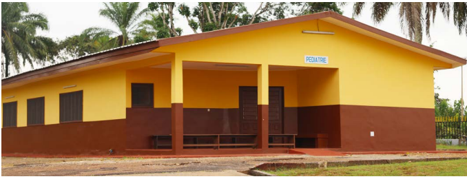
Bâtiment Pédiatrie réhabilité.
