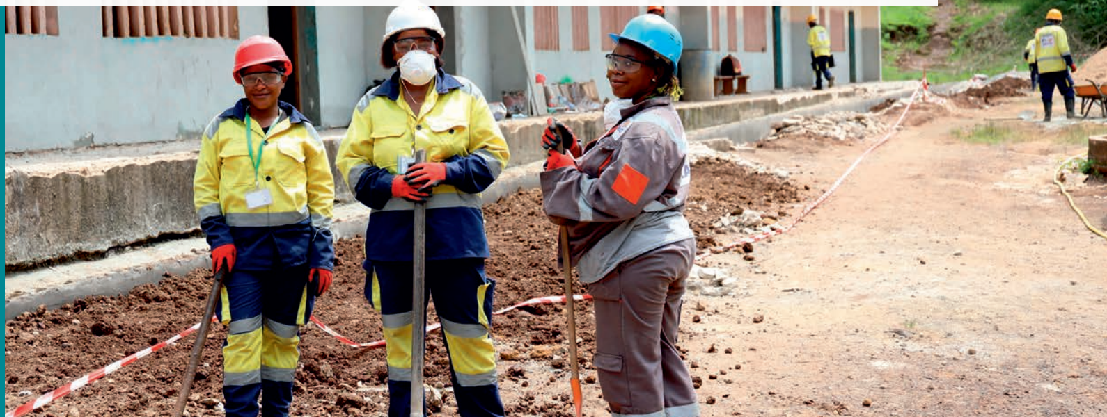
Les équipes de construction à pied d'œuvre...
