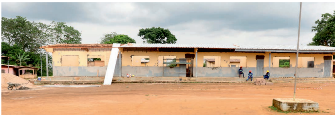
Bâtiment d'une école à Bakoumba en cours de réhabilitation.
