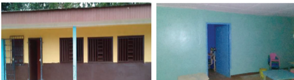
Image 11 : Salle de classe réhabilitée à l'école publique communale de Bakoumba
