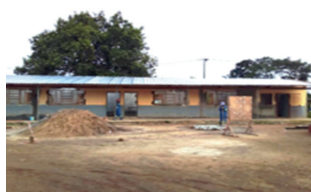
Image 9 : Travaux école catholique Saint Michel à Bakoumba
