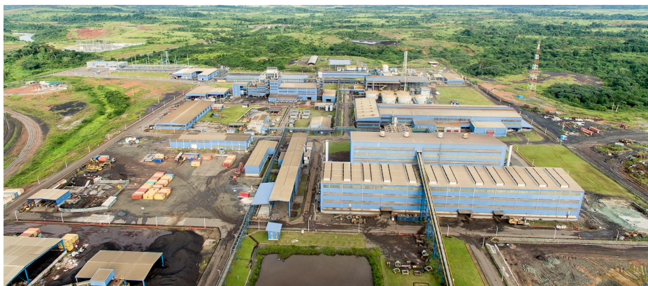
Vue aérienne du complexe métallurgique de Moanda.
