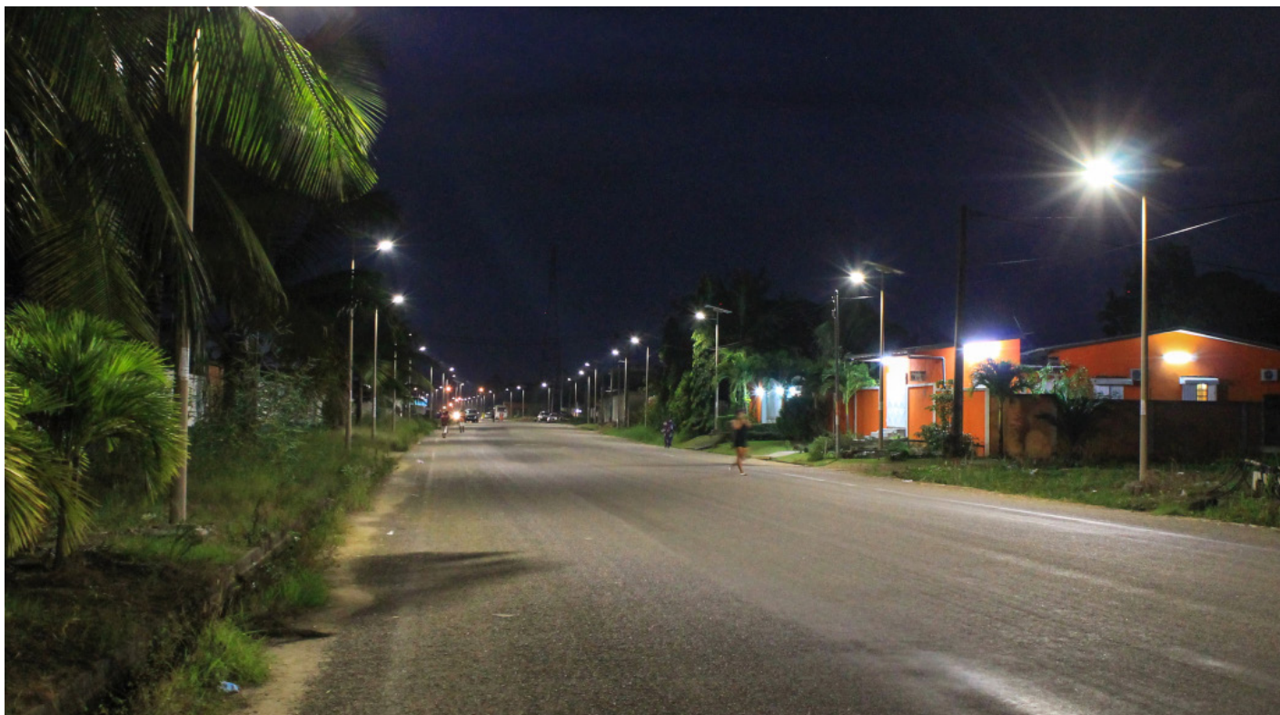
Les rues désormais éclairées par des lampadaires solaires.
